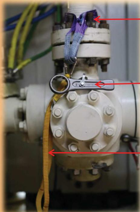
Ved sikring av verktøy og utstyr pass på at forankringspunktet er kraftig nok til formålet.
